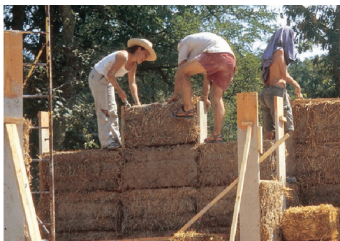
Fig. 21 : Mise en œuvre du système CST par Tom Rijven.
