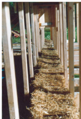
Fig. 17 : Double ossature bois du système GREB - JB Thévard.
