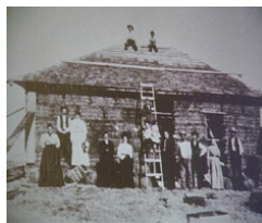
Fig. 4 : Construction d'une des premières maisons en paille au Nebraska - XIXème S aux USA.
